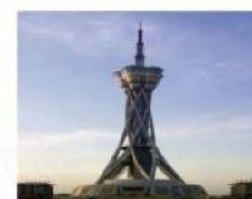
河南广电发射塔工程
