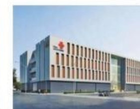
廊坊联通数据库项目
